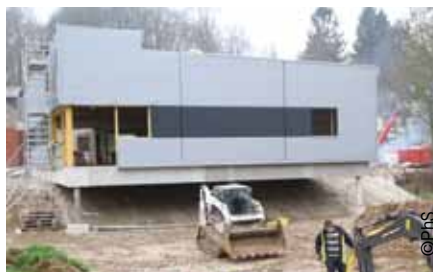
Construction d'une salle communale et d'une mairie à Fieffes-Montrelet
